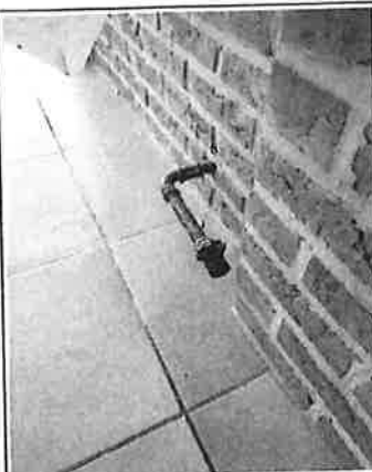
Foto 15: 61: indicatie van een risico op ontploffing/brand Woonkamer: open gasleiding
