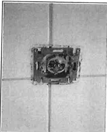
Foto 2: 51: indicatie van een risico op elektrocutie/brand Keuken: stopcontact met ontbrekende afdekplaat
