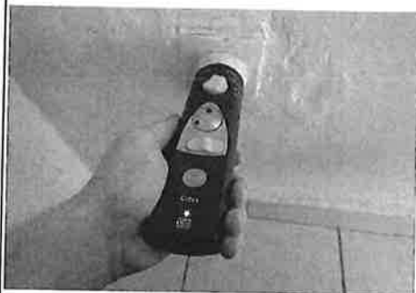
Foto 4: 51: indicatie van een risico op elektrocutie/brand Berging in keuken: stopcontact met pen zonder aarding
