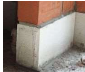
Aanzet binnenspouwblad op vloerplaat met Kimblok
