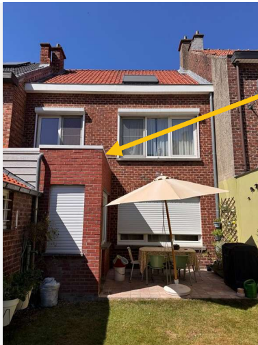
plat dak met roofing
