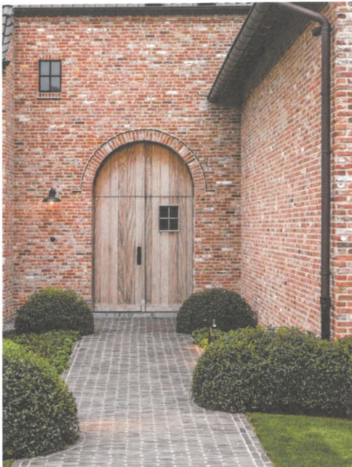
Klassieke houten gebogen voordeur in combinatie met rood genuanceerde gevelsteen
