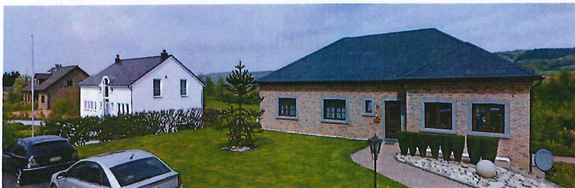
Figure 5. Cadre bâti le long de la N608
