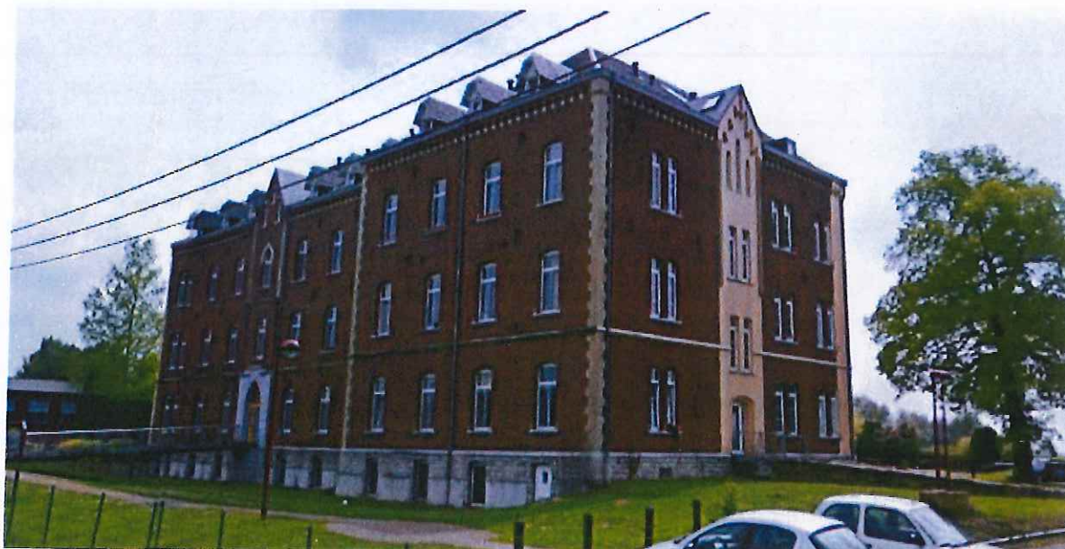
Figure 6. Bâtiment NOSBAU « Résidence Völkerich »
