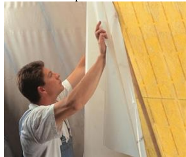
Aanbrengen van een dampscherm
