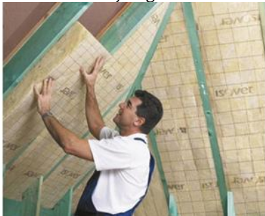
Plaatsing van dakisolatie met lambda-waarde 0,035 W/mK
