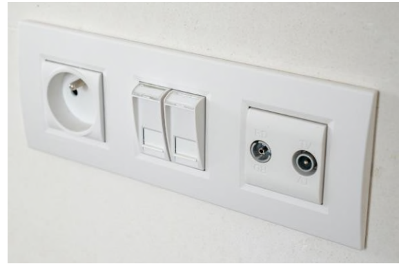
Stopcontact, internet- en tv-aansluitingen
