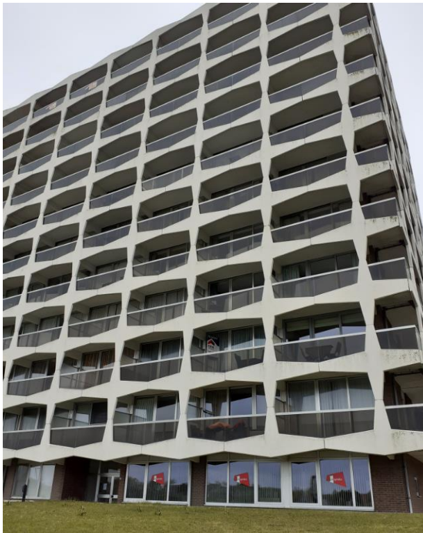
Figuur 3: Visuele beoordeling gevel: geen asbest aanwezig:
