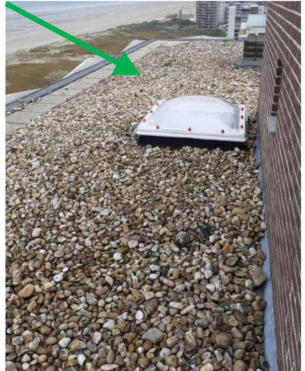
Figuur 9: Roofing(2017) onder de kei-laag : geen asbest aanwezig.
