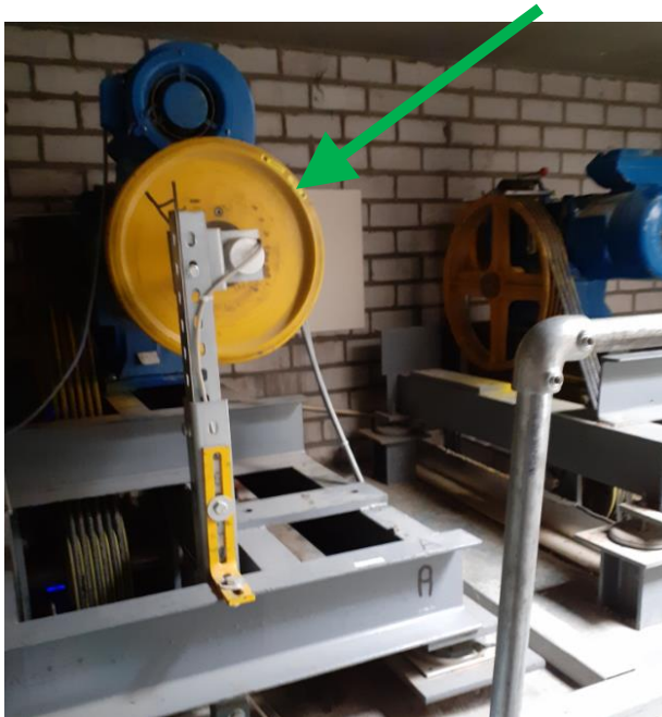
Figuur 6: Lift, remvoeringen van beide liften zijn vervangen zie attest van regularisatie Fig.8 & 9: geen asbest aanwezig.
