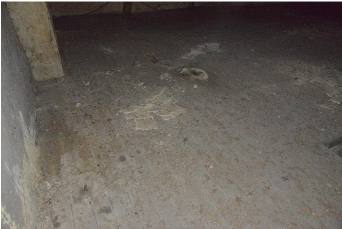
Vanaf de centrale steunmuur tot aan de westgevel, smalle planken, idem geschilderd.
