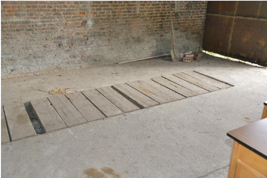
Cementvloer met later ingebrachte smeerput.
