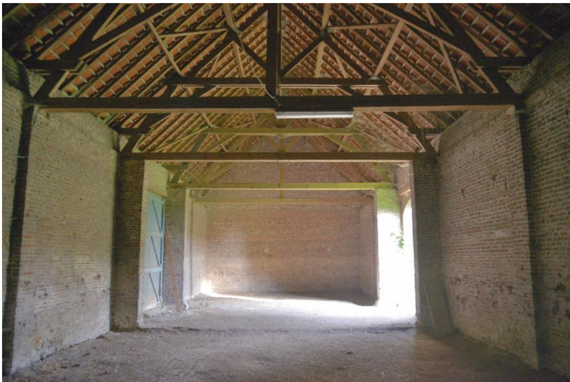
Binnenzicht naar de noordzijde
