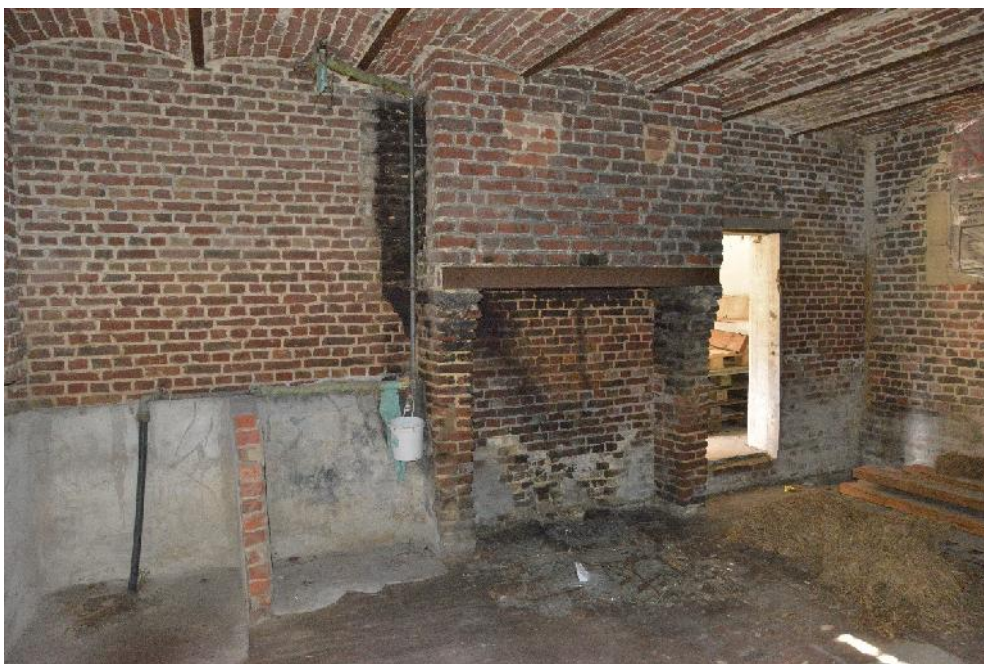
Idem afdekking in gemetselde gewelven tussen stalen I-liggers, oude baksteenvloeren.
