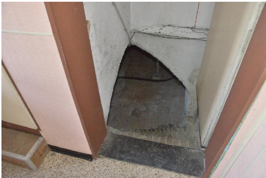
Toegang tot de kelder, gemetste verdreven trap, 6 treden.
