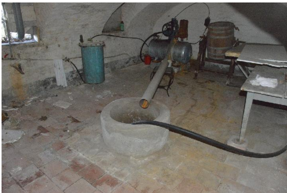
Kelder afgedekt met een tongewelf, witgekalkt of geschilderd met hoge zwarte plint. Los latende verf. Kelderraam aan de noordkant. Vloer in rode aardewerken tegels. Centrale waterput.
